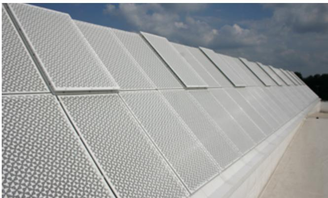
**3.9 Durchsturzsichere Bauteile**
